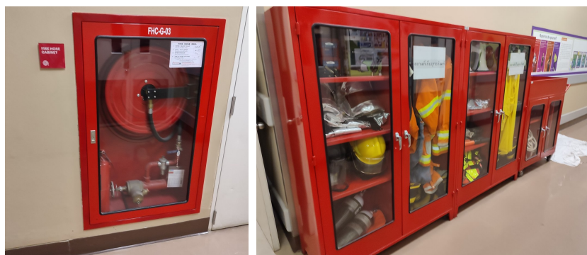
ภาพที่ 3-24 ตู้เก็บสายฉีดน้ำดับเพลิงและอุปกรณ์
