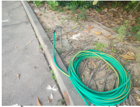
ภาพที่ 3-6 ก๊อกรน้ำเสียสำหรับรดน้ำต้นไม้พร้อมป้ายบอกว่าเป็นก๊อกที่มีน้ำผ่านการบำบัดน้ำเสียของโครงการ
