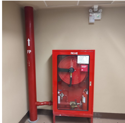
ภาพที่ 3-21 ท่อยืนสูบน้ำดับเพลิง และตู้เก็บสายฉีดน้ำดับเพลิง
