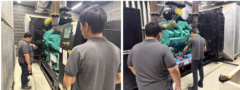
ภาพที่ 3-47 คูแลร์รักษา ระบบไฟฟ้าและทดสอบเครื่องไฟฟ้าฉุกเฉิน
