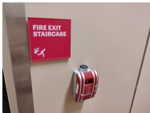
ภาพที่ 3-27 อุปกรณ์แจ้งเหตุเพลิงไหม้ด้วยมือ
